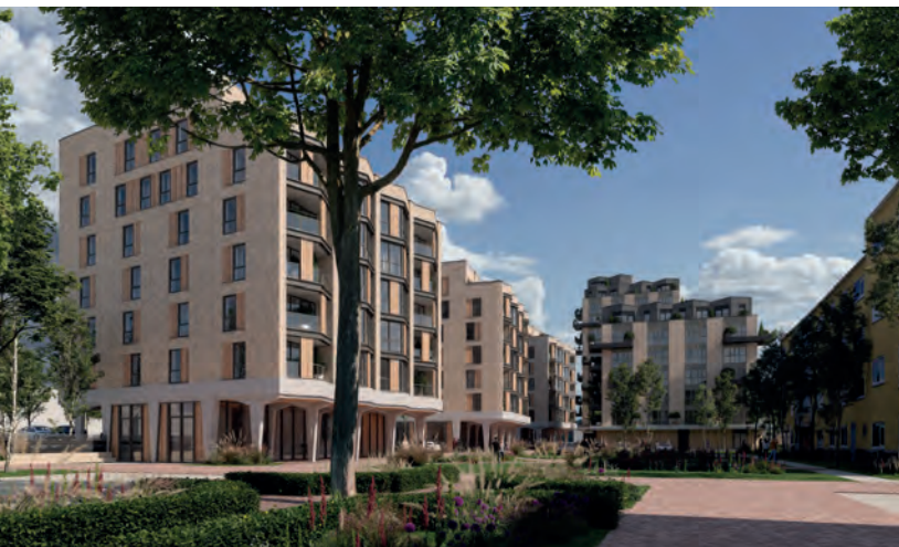
De buitengevels bestaan uit metselwerk. In de betonnen tafelconstructie op de begane grond zijn parkeren, bergingen en technische ruimten ondergebracht.
